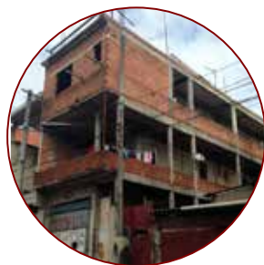
ausência completa de acabamentos e pisos externos
