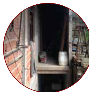
falta de guarda corpo e proteção para queda
