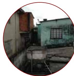
Parede externa com umidade e mofo, caixa d'água de fibrocimento exposta
